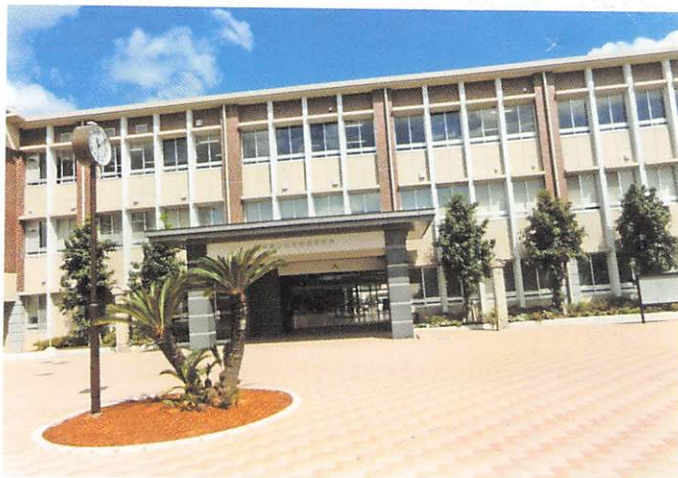
伝習館高の管理棟、玄関
